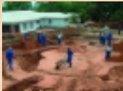
Baustelle St. Luke's – Infrastruktur verbessern
