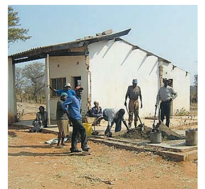
In Eigenregie wird die Lehrerwohnung einer Schule gebaut.
